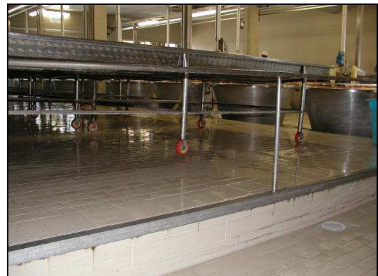
Fig. 5 – area vasche di affioramento su piano rialzato (con parapetto) rispetto alle caldaie
